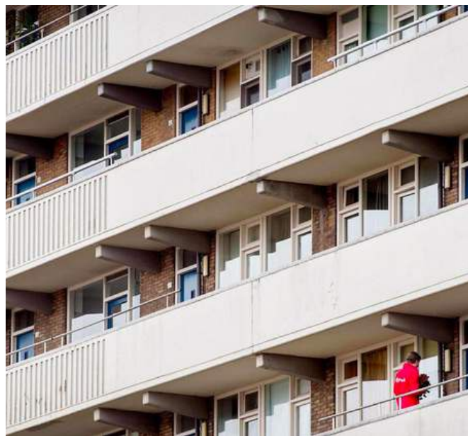
Verduurzamingswerkzaamheden Eigen Haard.
